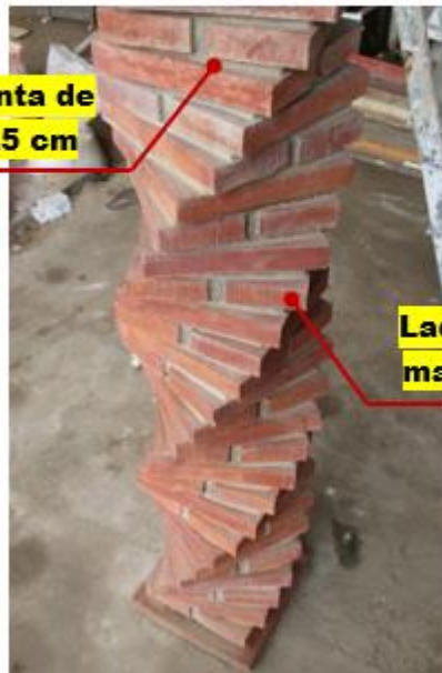
Columna sin núcleo de concreto
